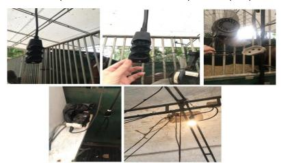
irregular "gambiarra" nas cocheiras pré-montadas (lona verde), bem como nos pavilhões do clube. Os circuitos são dimensionados para atender adequadamente as necessidades de cada cocheira. A instalação de outros equipamentos pode, além de causar sobrecarga desligando o sistema elétrico, também ocasionar eventuais curtos interrompendo a alimentação por longos períodos"
